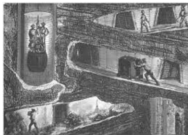
Les tunnels de transport du charbon
